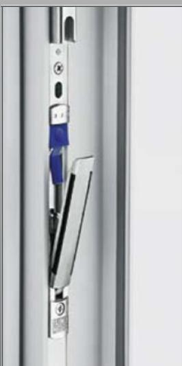
Le système à pivot permet un réglage tri directionnel très précis, il permet également de bien mieux répartir le poids du vantail, il est alors facile d'équiper la fenêtre de complexe vitré très lourd.
